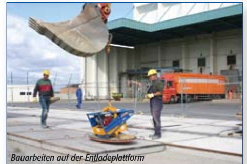
Bauarbeiten auf der Entladeplattform
