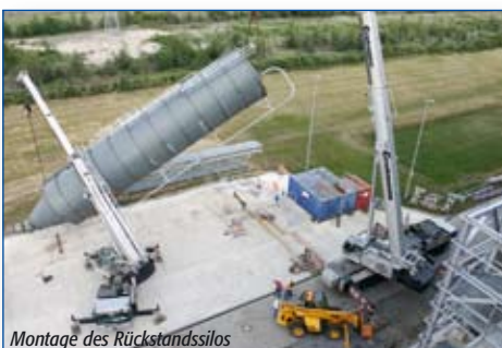
Montage des Rückstandssilos
