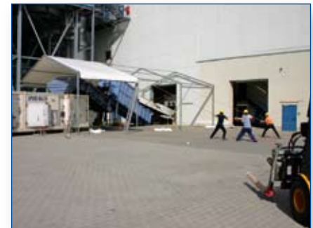
Ein Zelt für die Ballierungsanlage
