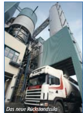
Das neue Rückstandssilo
