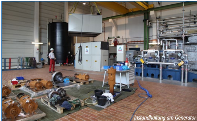
Instandhaltung am Generator
